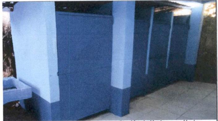
Foto 4: Puertas de metal en baños y sustrucción de lámina, por lámina troquelada calibre 26
