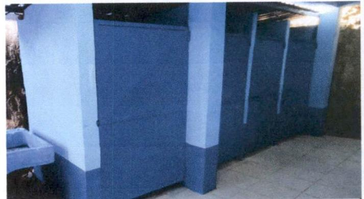
Foto 4: En la fotografía se aprecian las paredes de block con columnas de hierro y concreto
